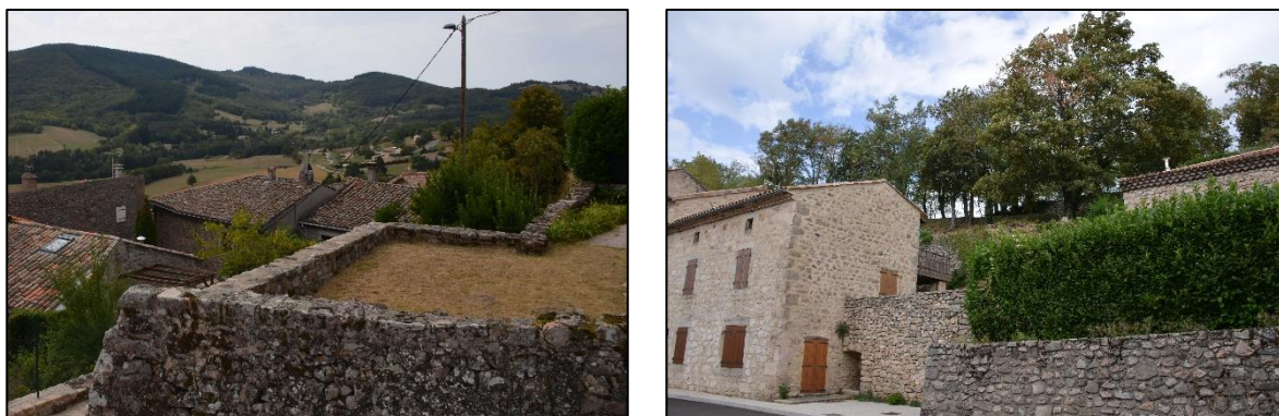
Bâti traditionnel implanté dans la pente
