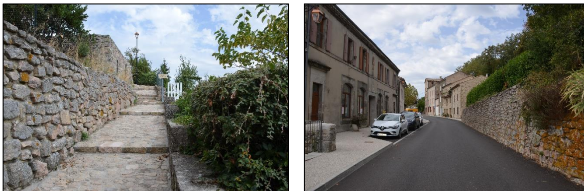
Aménagements récents dans le bourg : calade et traversée du bourg
